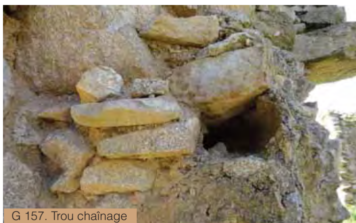
G 157. Pierre de ramassage composant un mur
