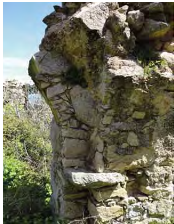
G 157 - étage. Pendentif, témoin de l'existence d'une coupole
