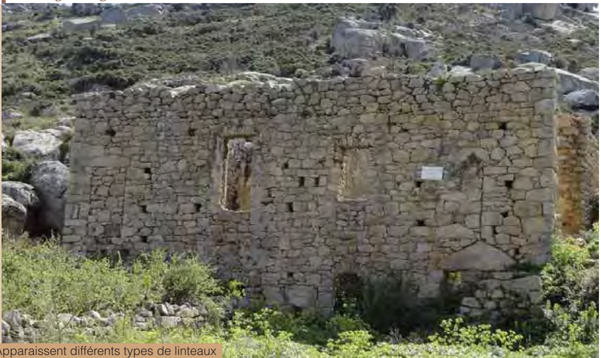
Chaînage d'angle et trous de boulins
