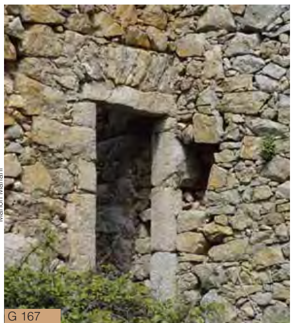
Linteau et arc de décharge à plate-bande >
