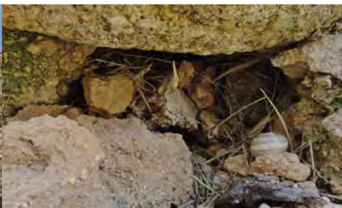
G 157. Paille en guise d'isolation pour les montants des menuiseries
