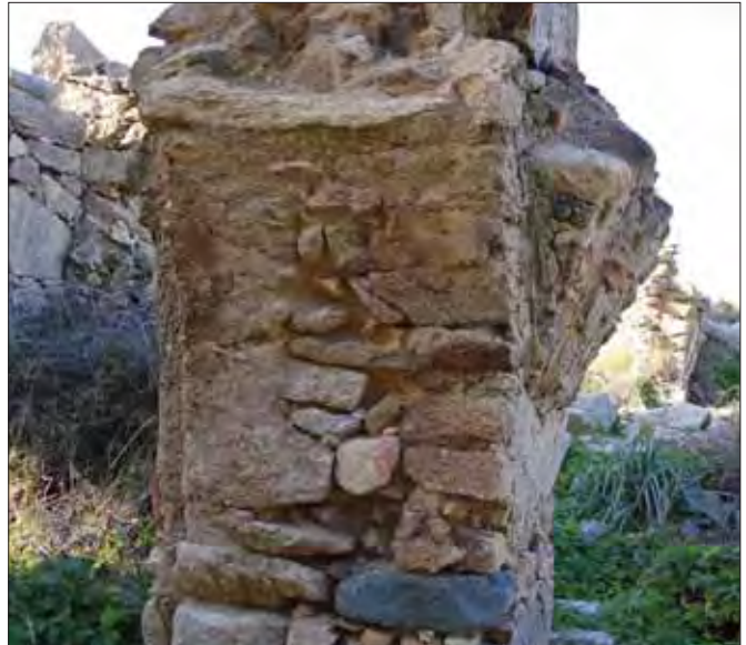
Départ de voûte supportant le plancher supérieur G 157
