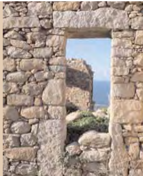
Ci-contre linteau monolithe datable du 18 e ou 19 e siècle
