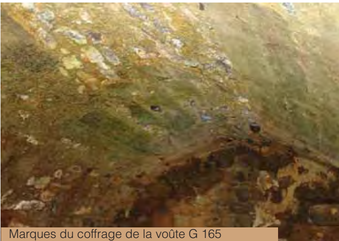
Voûtes et coupoles pour soutenir le plancher supérieur - RDC Maison Giudicelli G 157
